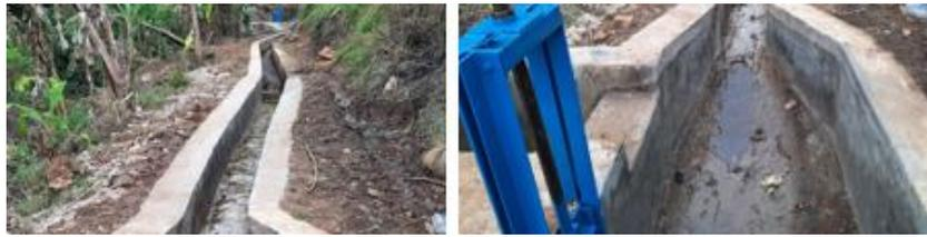
Gambar 5. Perbaikan saluran pembawa dan bak penenang
