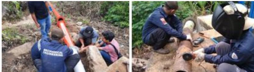
Gambar 6. Perbaikan pipa pesat
