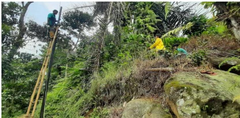
**Gambar 10. Pemasangan kabel listrik pada tiang listrik untuk penerangan jalan umum**
