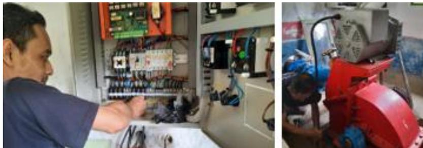
Gambar 9. Penggantian pabel sistem kontrol dan generator 3 phase
