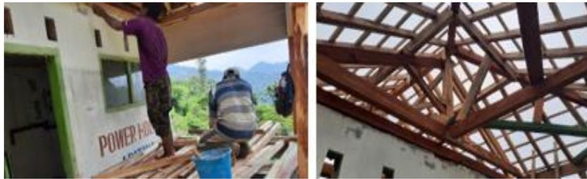
Gambar 7. Perbaikan atap dan plapond rumah turbin
